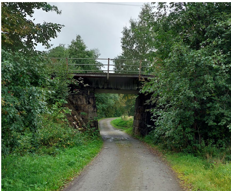
Figur 7 - Landbrukskulvert ved Loddbekken
